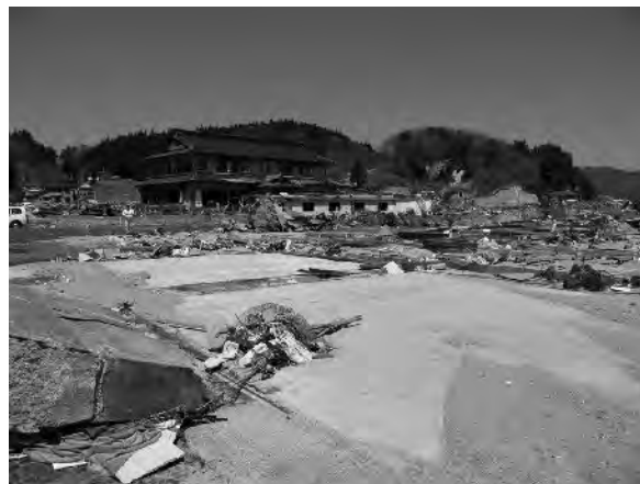
コンクリートの基礎だけ残った山田町文化財収蔵庫
