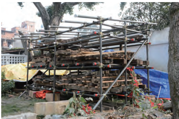
図 5-10 装飾部材収納状況
