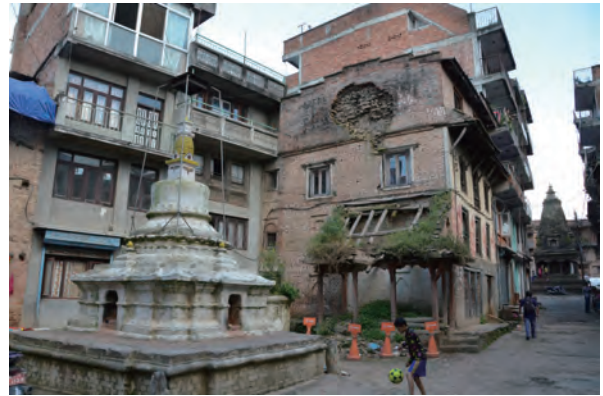
図 2-16 キルティプル内の被災状況
