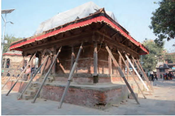
図 2-28 上層が崩壊したカゲシュワル寺 (Kageshwar)
