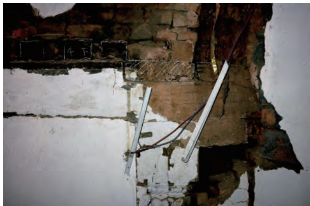
図3-26 モハン・チョク南棟境の桁痕跡 (3階階段室、白黒の斜線は桁仕口の痕)
