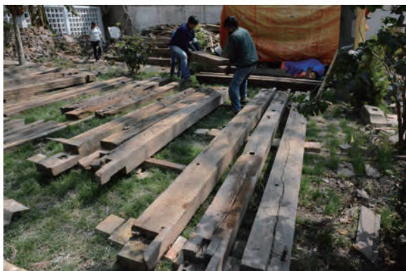
図 5-8 構造部材整理状況
