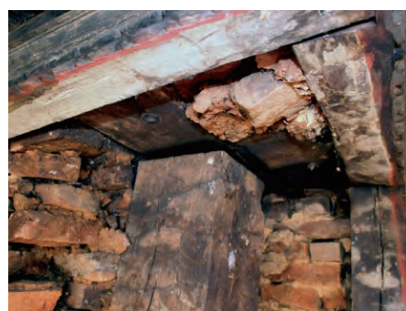
図3-17 バイラブ寺の壁内柱
