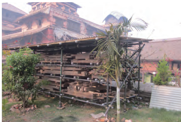
図 5-11 構造部材収納状況
