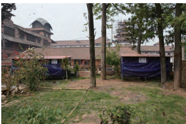
図 5-12 部材収納完了
