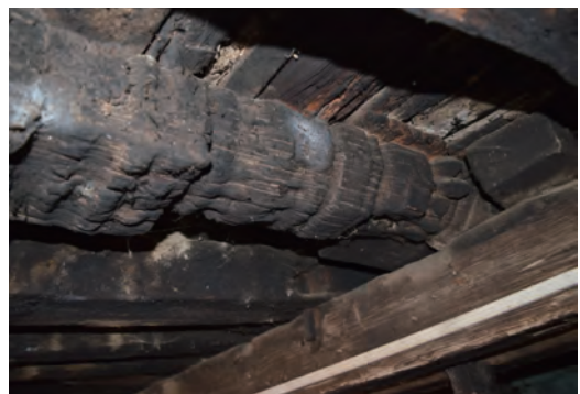
図 6-16 1階の梁として転用されていた装飾的柱
