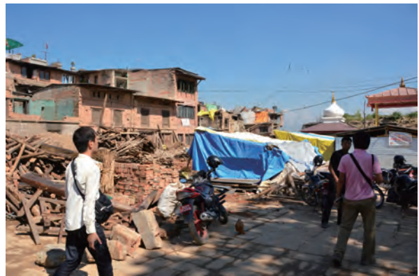
図 2-22 ブンガマティの被災状況
