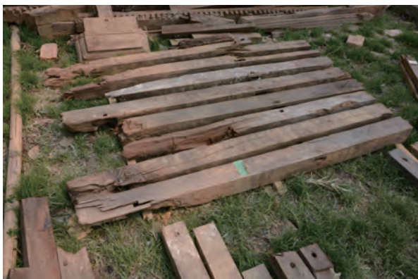
図 5-14 初層煉瓦壁内周柱材
