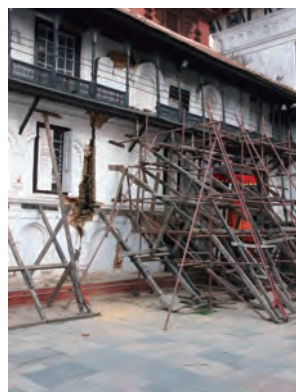
図3-22 アガンチェン寺階下 西側外壁
