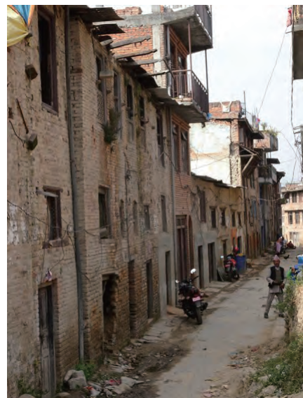
図6-9 半壊した伝統工法建物の一例
