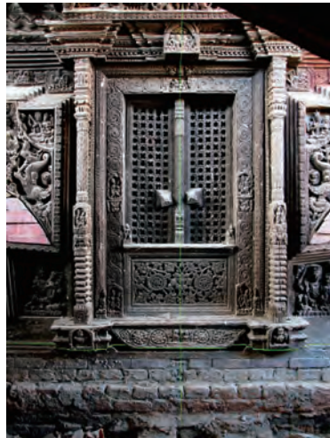
図3-24 アガンチェン寺初層東側 (緑色のレーザー線が水平・垂直を示す)
