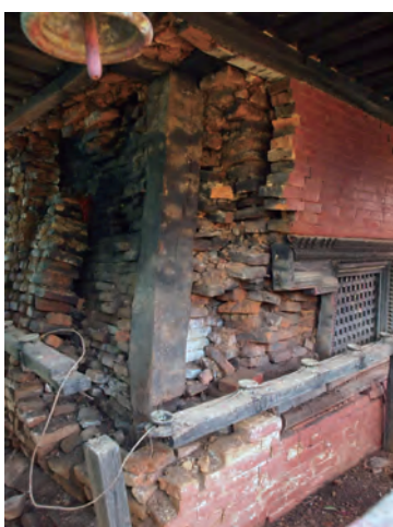
図3-15 南西隅の壁内柱
