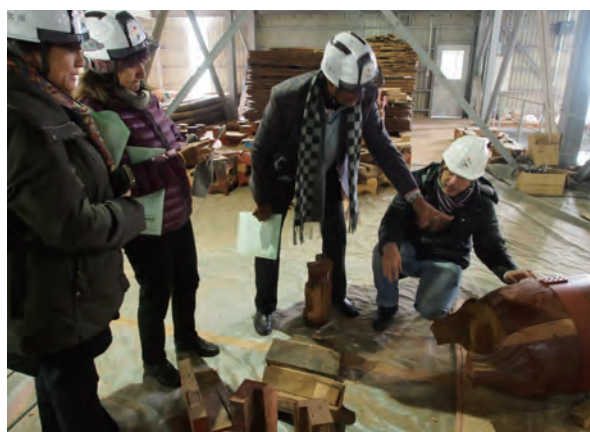
図 1-14 日光輪王寺三仏堂修復現場見学
