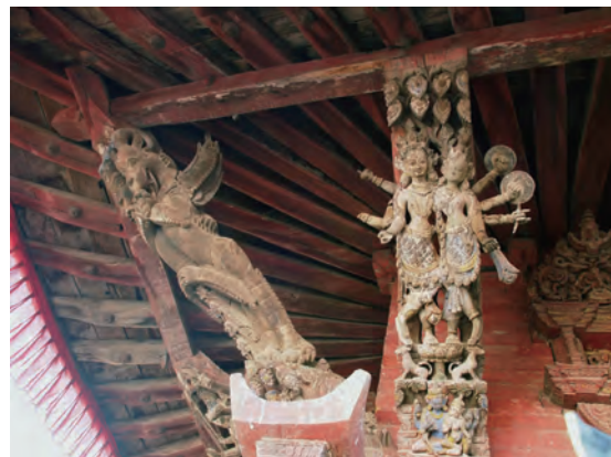
図3-21 アガンチェン寺初層東側(左の方杖がクンサル)
