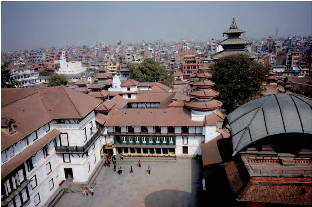
図3-6 震災前のカトマンズ王宮ハヌマンドカ俯瞰 2015年2月 photo by T. KUROTU & JCIC-Heritage
