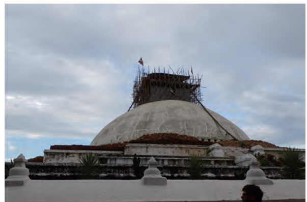
図 2-12 傘蓋部が解体撤去された大ストゥーパ頂部
