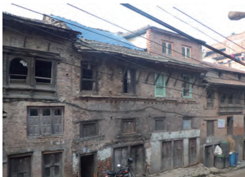
図 6-17 1934年地震前から残る住宅（一部増築）
