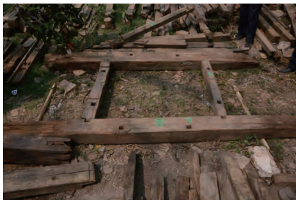
図 5-15 小屋組材と推定される部材
