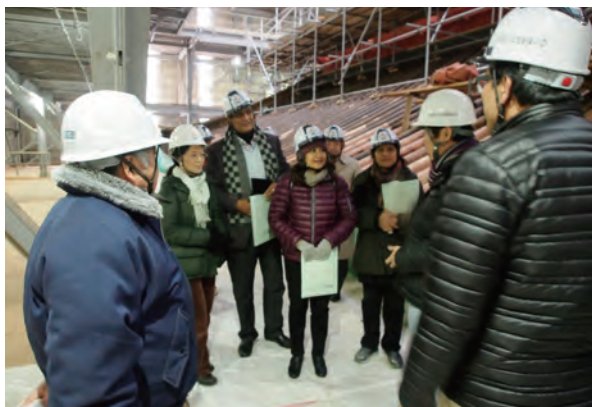
図 8-36 日光輪王寺修復現場見学 1
