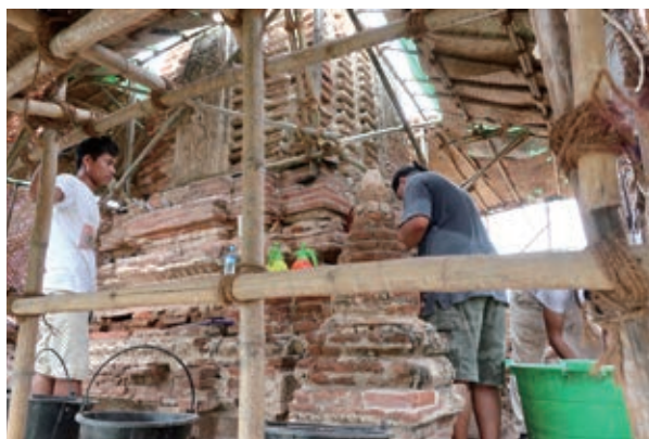
寺院頭頂部の作業風景 Ongoing work at the pagoda dome
