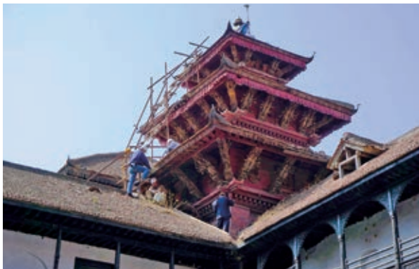
アガンチェン寺屋根の瓦葺仕様調査 Survey of tile-roofing specifications at the Aganchen Temple
