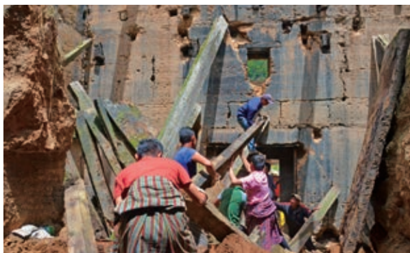
倒壊部材の回収作業
