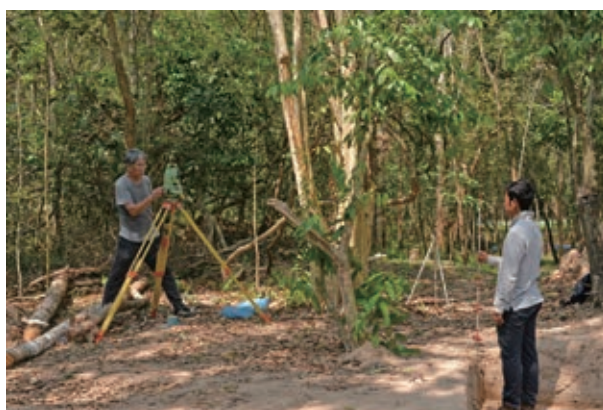
測量調査の様子 Ongoing precise survey
