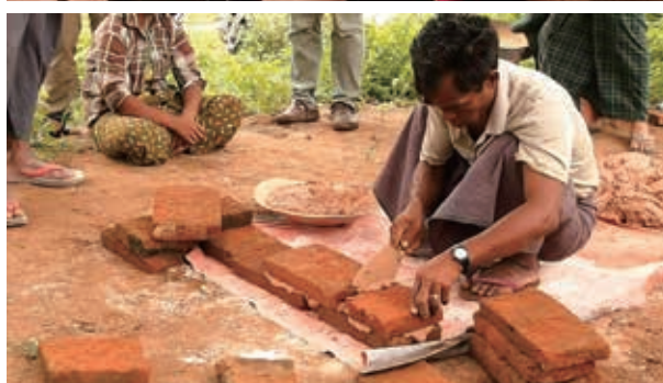
技法調査（上）と現地職人による煉瓦積み実演 Technical survey (upper) and performance by local bricklayer
