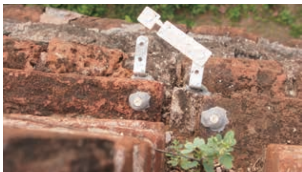
リスによるクラックゲージの破損とクラックディスクの設置 Crack gauge damaged by squirrels and installation of crack disks
