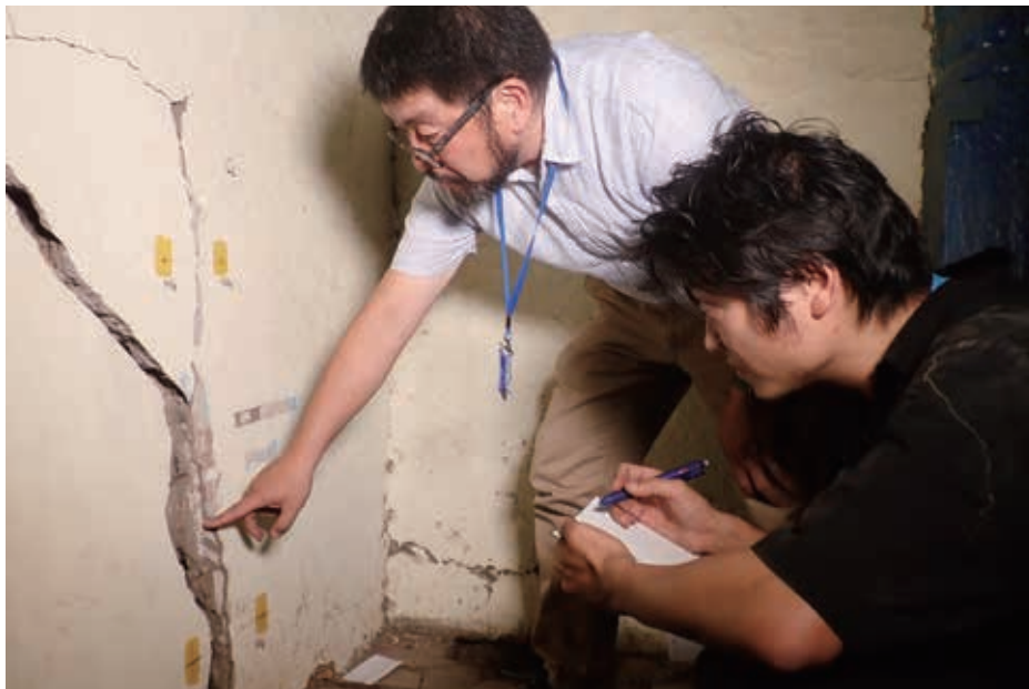
カトマンズ・ハヌマンドカ王宮内における壁面仕上げ調査 Investigation on the wall surface finishing at Hanumandhoka Palace, Kathmandu
