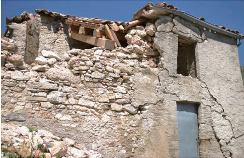
サン・クリストーフォロ教会被災状況（外壁） The state of the damaged Saint Christopher (San Cristoforo) Church (exterior walls)
