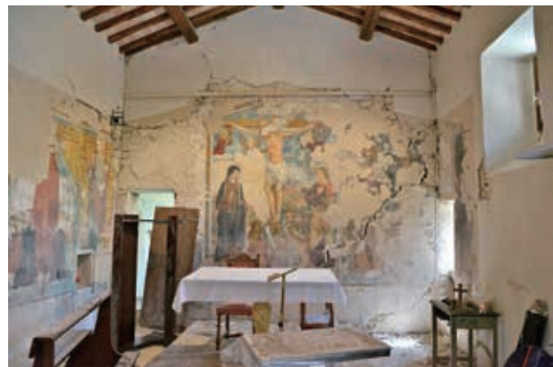
サン・クリストーフォロ教会被災状況（内部壁画） The state of the damaged Saint Christopher (San Cristoforo) Church (interior mural paintings)
