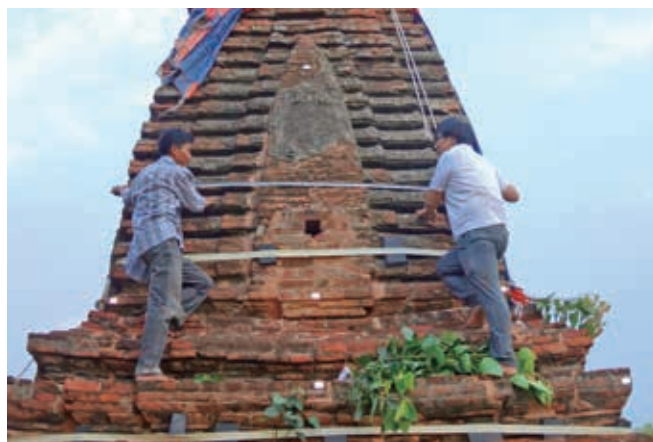
図2 変形測定のためのターゲット設置作業 Installation of targets for deformation monitoring
