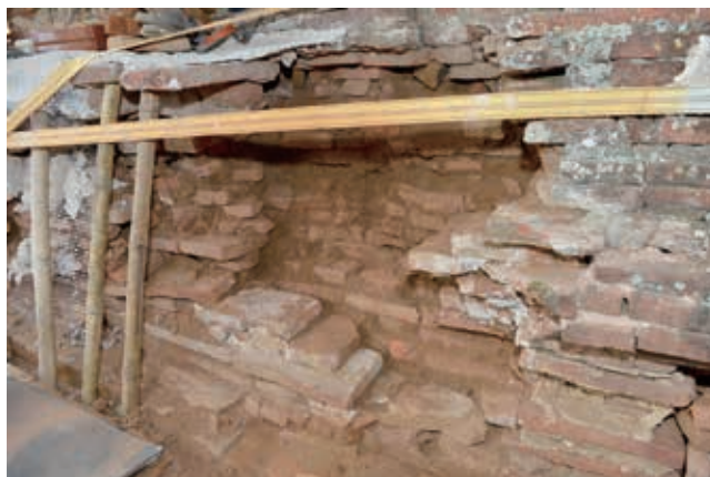
震災により崩壊した外壁の修復処置 Restoration of the quake-damaged outer wall
