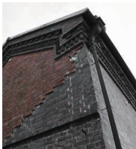
写真2：旧野村さとう店煉瓦蔵の保存修理後の煉瓦壁面（筆者：ズレた壁面を強調するため色加工）
