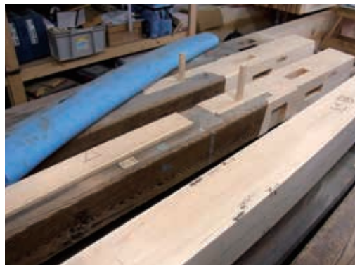
伝統的木工技術による古材の補修（日本） Repair with traditional carpentry techniques (Japan)
