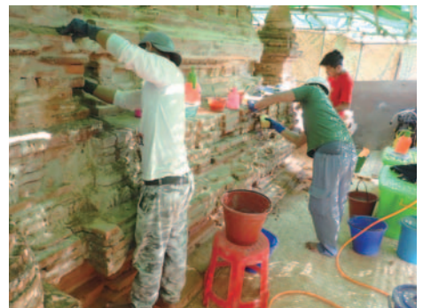
煉瓦造寺院の保存修復に関する研修(ミャンマー・バガン) Training workshop for the conservation of a brick temple (Bagan, Myanmar)
