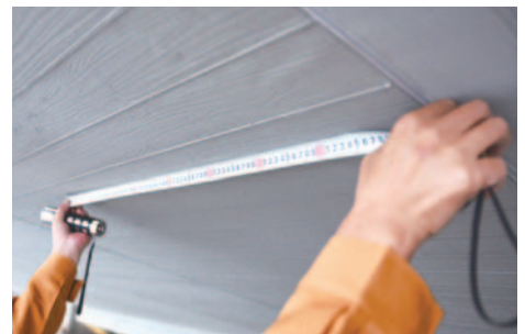
再現された型枠木目の調査(広島平和記念資料館)
