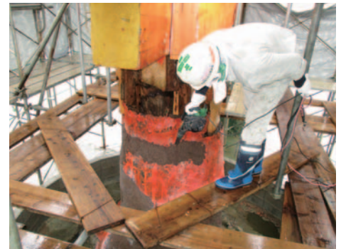
研究成果を生かした材料で修復される巖島神社大鳥居修理 Restoration work for the torii gate of Itsukushima-jinja shrine using restoration materials evaluated in this project
