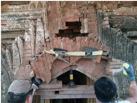
地震被災箇所の保存修復
